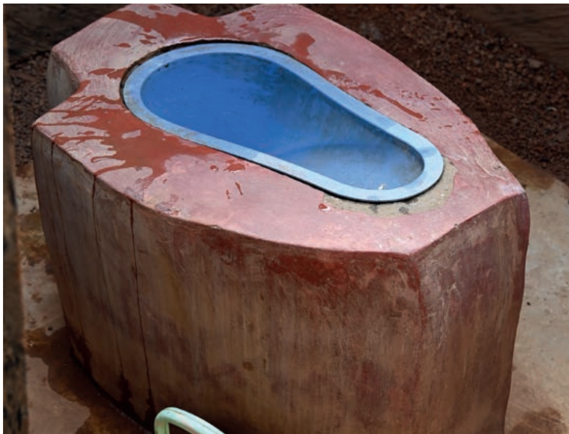
Photo 11 : Vérification d'une latrine construite au cours de l'évaluation du SanMark
