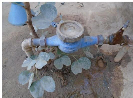
**Photo 8 : perte d'eau en amont d'un compteur Branchement Privé, non fonctionnel à Bangui**
