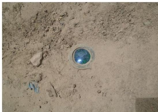
**Photo 10 : compteur Branchement Privé totalement enterré, non fonctionnel à Kantché**
