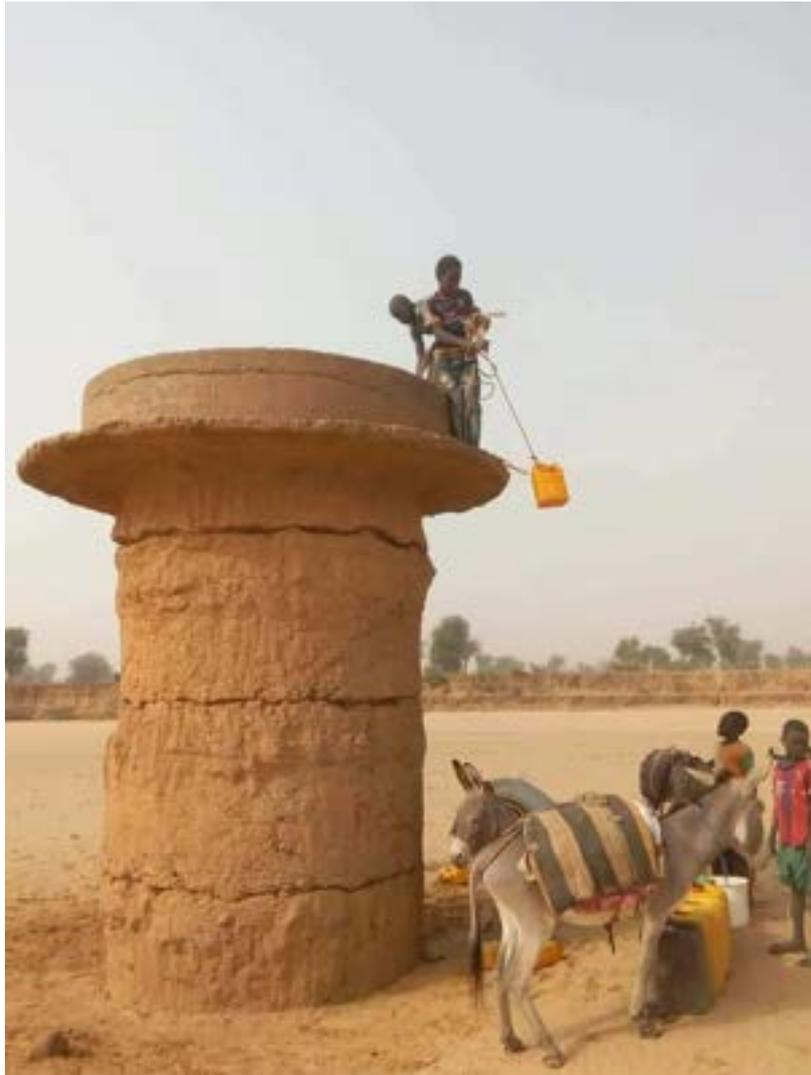
Photo 2 : Effets néfastes de l'érosion sur un puits cimenté
