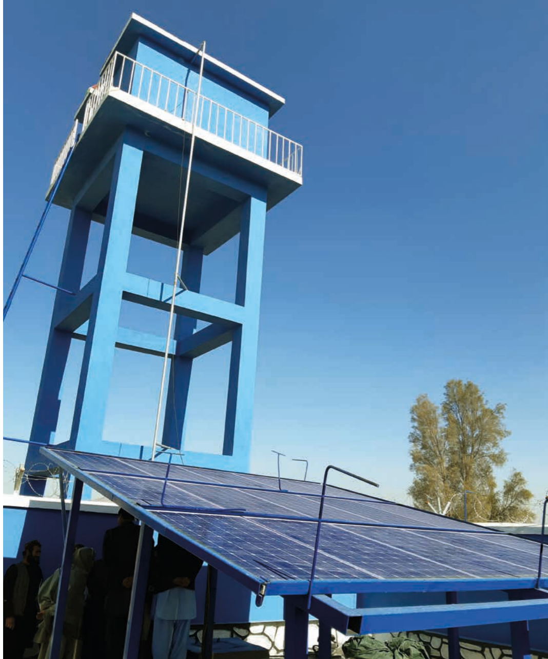
Système d'approvisionnement en eau alimenté à l'énergie solaire (Afghanistan).
