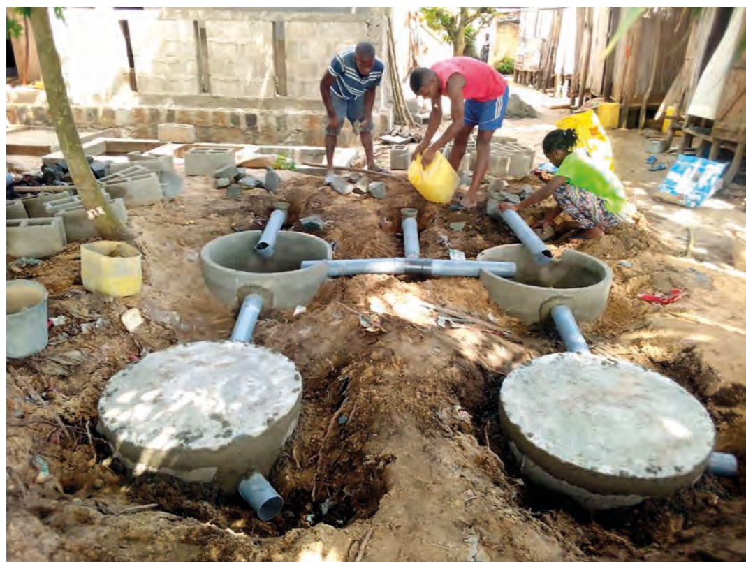
Construction de latrines (avec réservoirs de collecte) à Madagascar.
